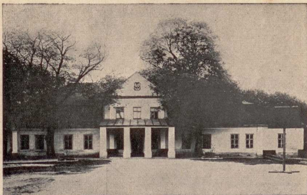
GLÓWNY BUDYNEK SZKOLNY
