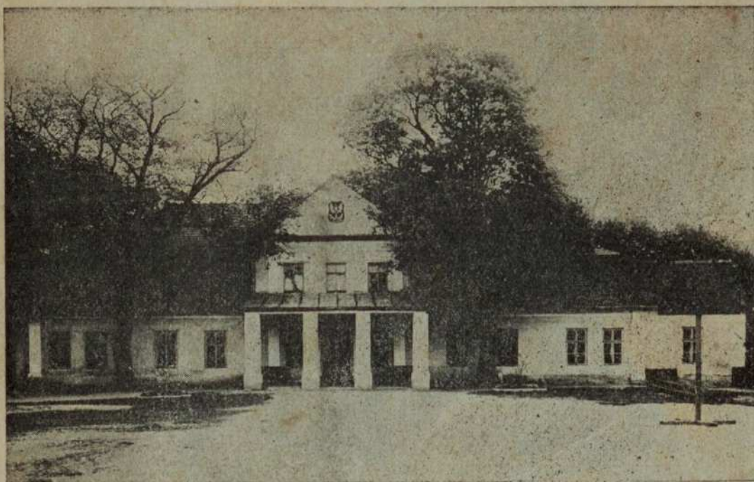
GLÓWNY BUDYNEK SZKOLNY 06 55 54
